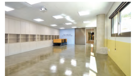
2층 교육장 벽면 및 바닥공사
